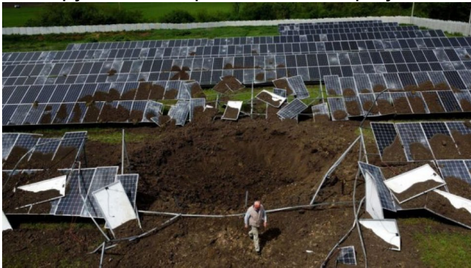
Рисунок 35: Мерешинська сонячна електростанція у Харківській області, частково пошкоджена російськими атаками. Фото: Solar Generation
